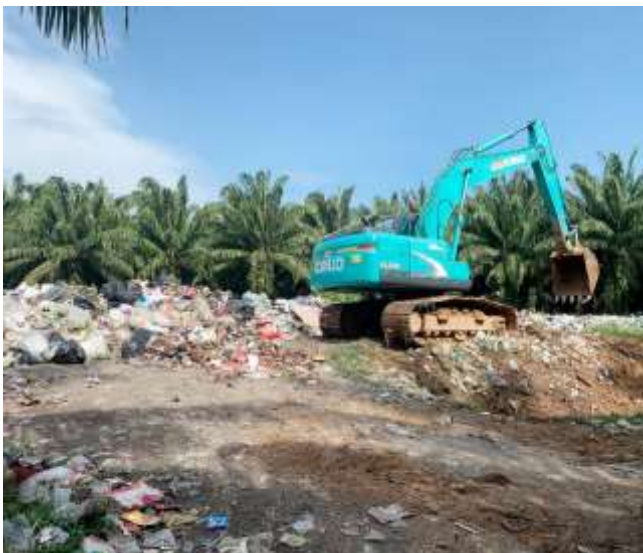
โครงการปรับปรุงบ่อขยะ
